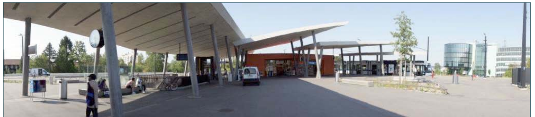
Abb. 9: Panorama Richtung Hochbord, Wallisellen, © Litscher.
