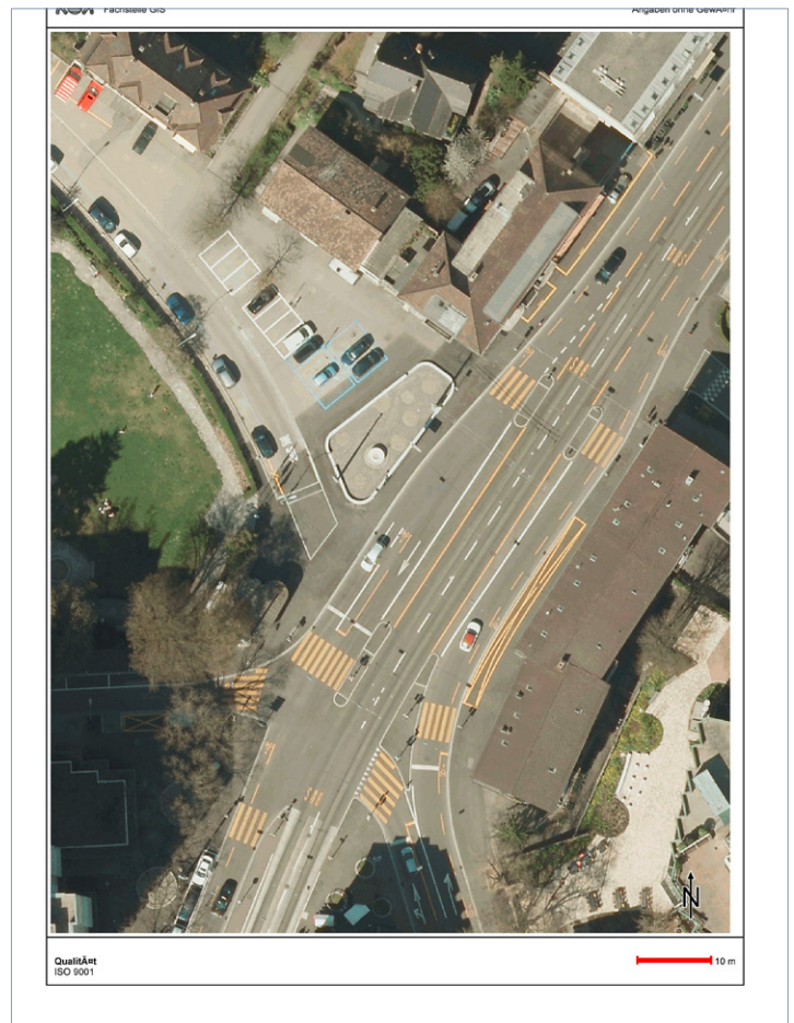
Abb. 2: TAZ GIS Flugaufnahme Schaffhauserstrasse (2011, während Bauarbeiten)
