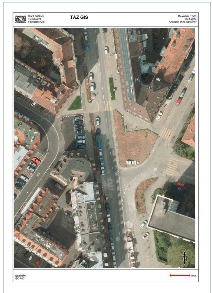
Abb. 3: TAZ GIS Flugaufnahme Anny-Klawa-Platz (2011 während Bauarbeiten)
