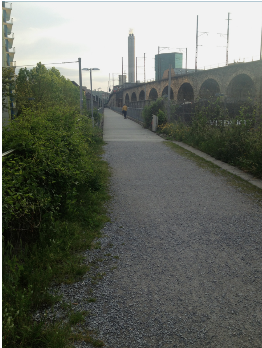
Abb. 9: Blick zur Kehrichtverbrennung auf Lettenviadukt, Bildquelle Simone Gämamm/HSLU.
