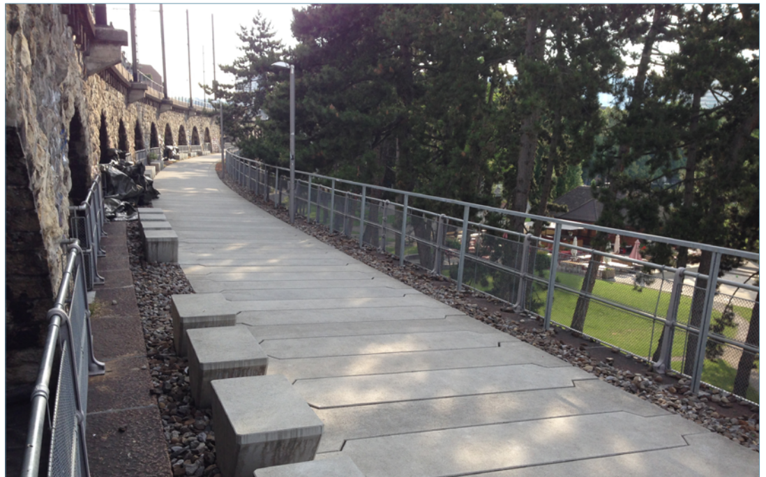
Abb. 10: Lettenviadukt links flankiert mit Bahngeleise und Bögen, rechts mit Josefweise, Bildquelle interface.
