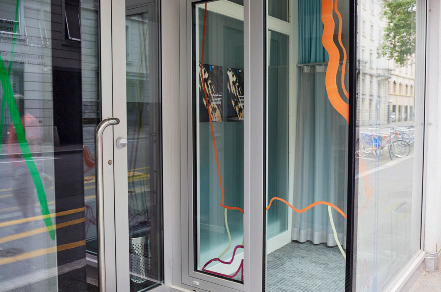
Abb. 3 Eingang Anlaufstelle Alter
