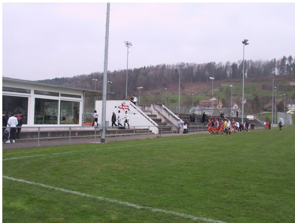
DA 4.32: SPORTANLAGE HOFSTATTMATTEN IN SUHR
