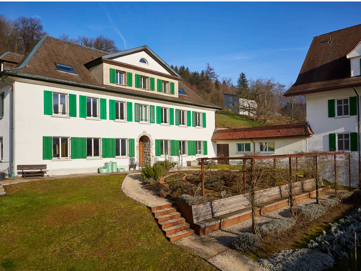
Abb. 3 Aussenbereich am Standort mit Gelände- abstufungen
